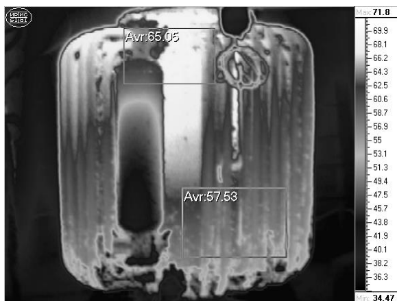
Рис. 2. Термограмма испытуемого трансформатора.
