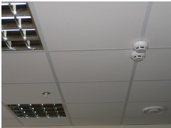
Рисунок 1.3 – Приклади розміщення пожежних сповіщувачів за наявності на стелі світильників
