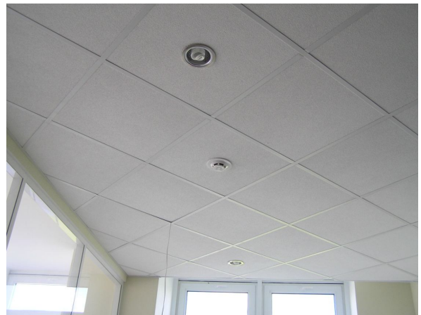
Рисунок 1.3 – Приклади розміщення пожежних сповіщувачів за наявності на стелі світильників
