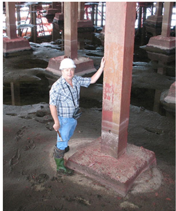
Рис. 6. Підсилення системи фундаментів градирні на ТЕЦ-5 за участю доцента В.О. Бондара (2018 — 2019 рр.) [Архів кафедри]
