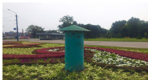
Рис. 1. Дегазаційні установки, встановлені на каналізаційних мережах м. Харкова
