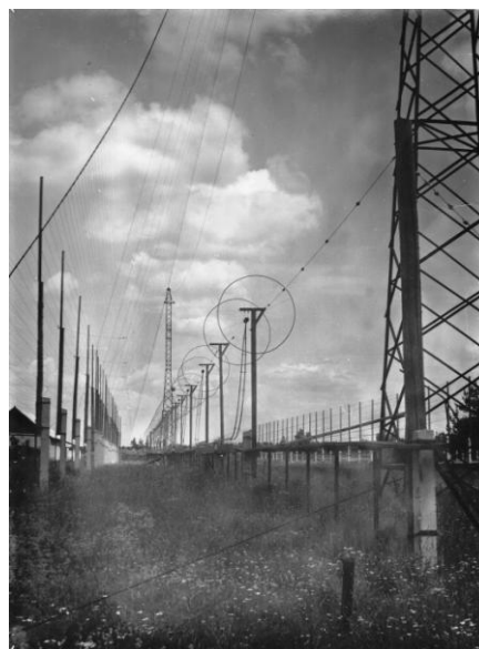
Рис. 4. Передаточная и приемная антенны МАРС для регистрации численности и орбит метеоров 1972 – 1978 гг. (Балаклейский полигон Харьковской области, рабочая частота 31,1 МГц)
