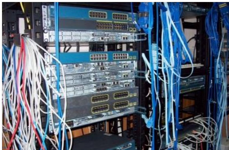
Рис. 5.1. Мережне обладнання виробництва компанії Cisco Systems на кафедрі інфокомунікаційної інженерії ХНУРЕ
