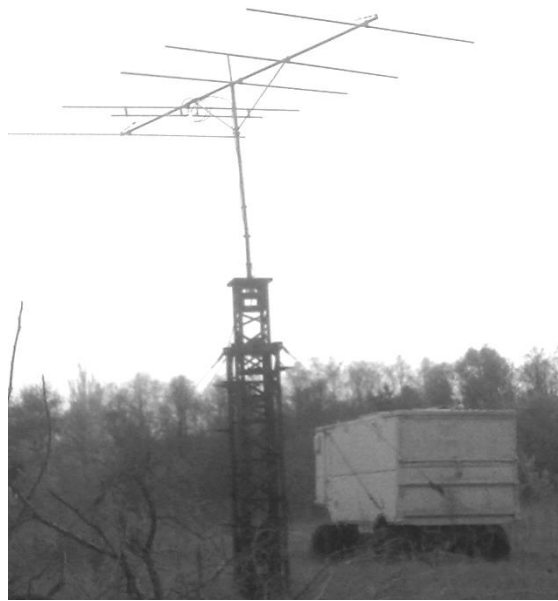
Рисунок 1.12 – Антена типу хвильовий канал для МРЗ
