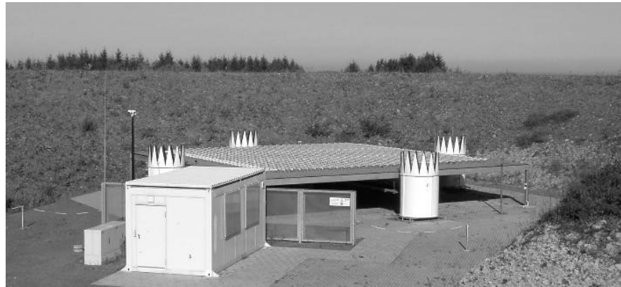
Рис. 1.9. Система РАЗ установленная в Германии в Линденберге
